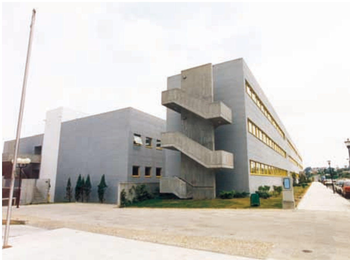
Escola Técnica Superior de Camiños, Canais e Portos (Campus Elviña, A Coruña).
